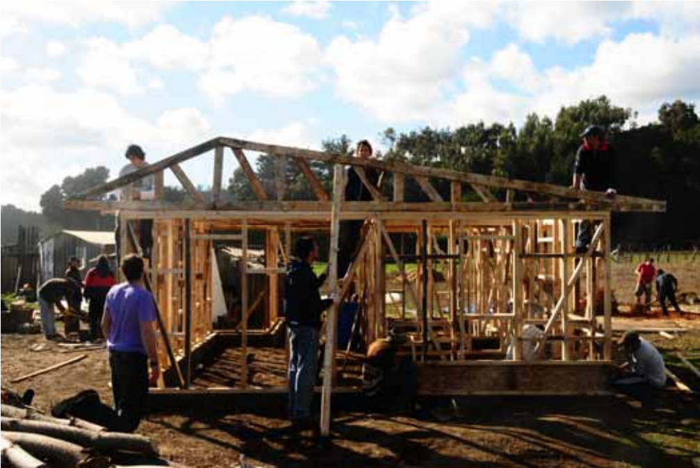
ESTRUCTURA DE MADERA
