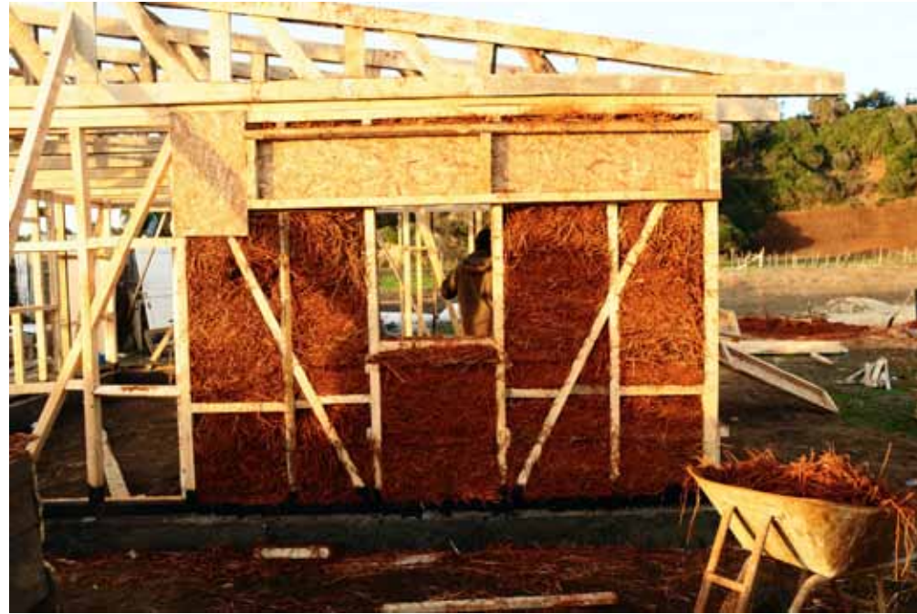
RELLENO DE MUROS
